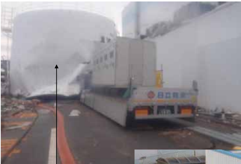
重油タンクが漂流し、道路を完全に塞いでいる
