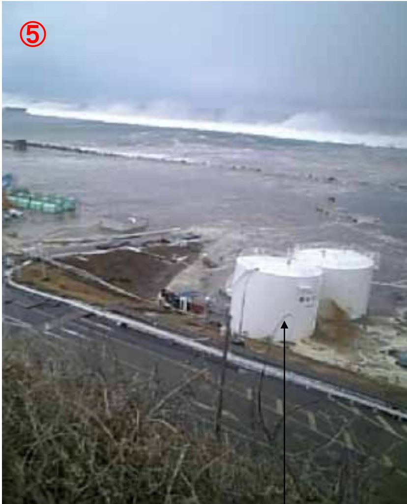
重油タンク2台が流されて、道路側へ乗り上げている
