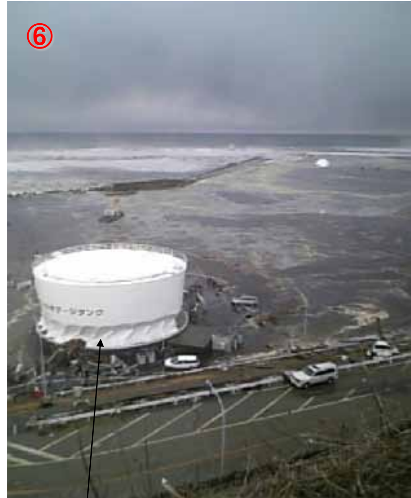
巨大なサージタンクは、ペットボトルを捻ったかの様に全周辺がよじれている
