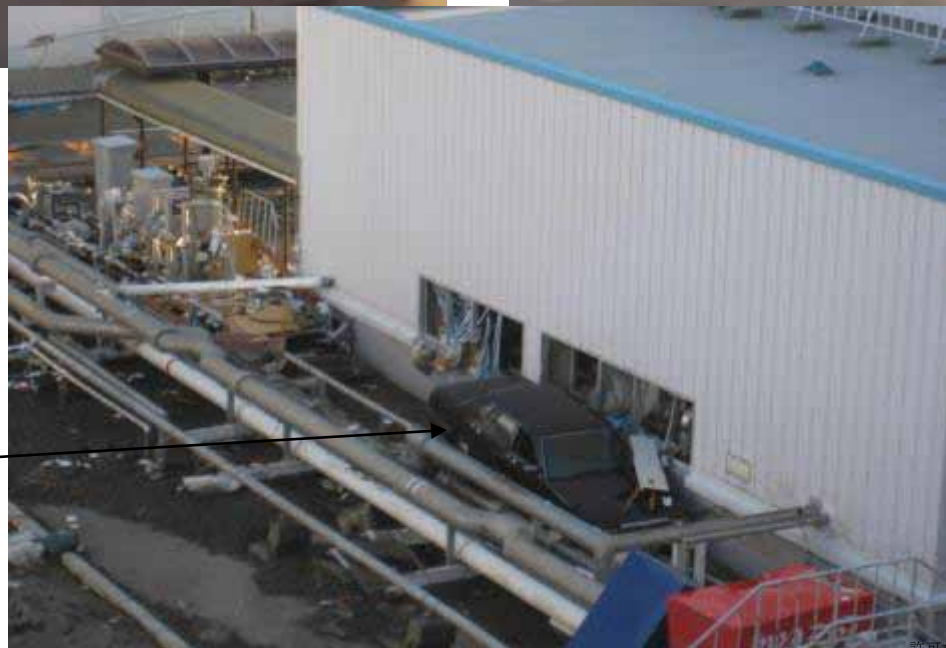
クレーン車(重量約45t)とガレキが漂流し、建物へのアクセスを妨害
